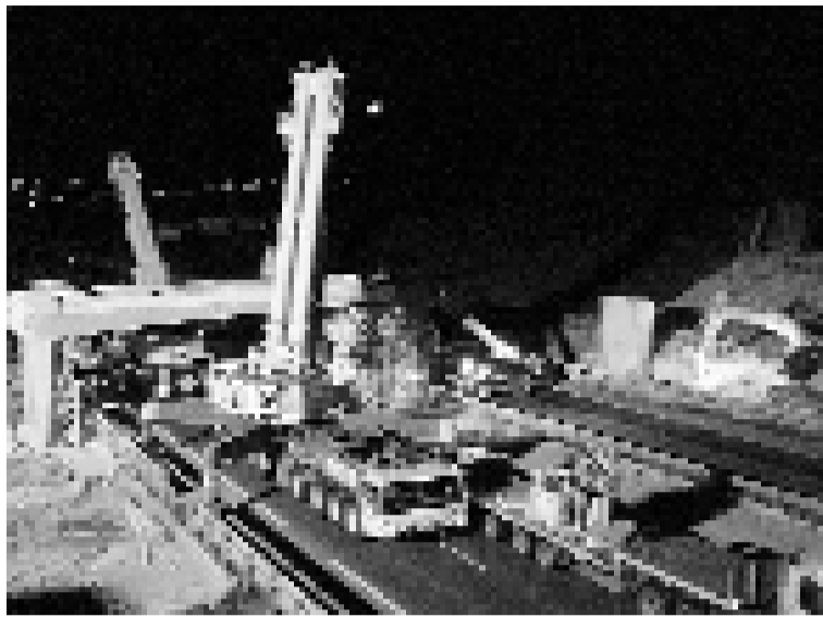
Alguna noche fue necesario cortar la autovía.
